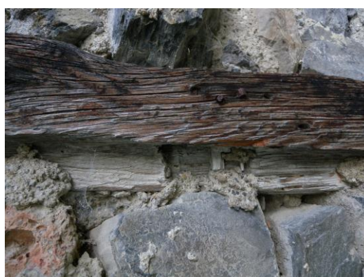
Poutre de 25cm de section et > 4 m de long à Chauvac (26) ; Linteau Le-Lauzet-Champcontier (04) ©L. Chaber /EPI
