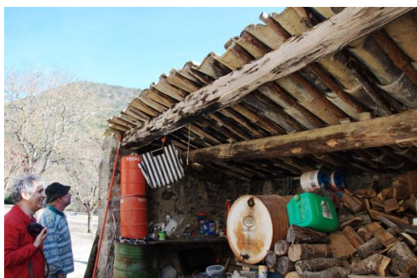
Poutre de 25cm de section et > 4 m de long à Chauvac (26) ; Linteau Le-Lauzet-Champcontier (04) ©L. Chaber /EPI
